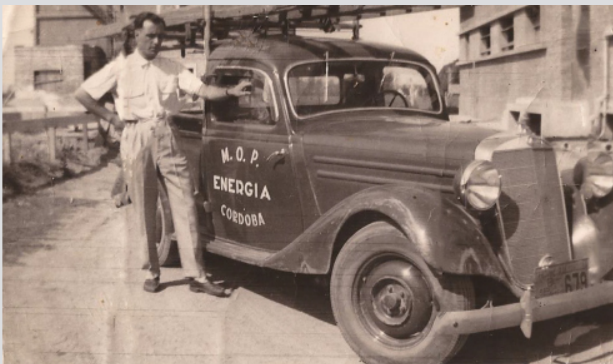
Compañero Bortolato junto a uno de los móviles utilizados para reparaciones en la calle, durante el año 1958.
